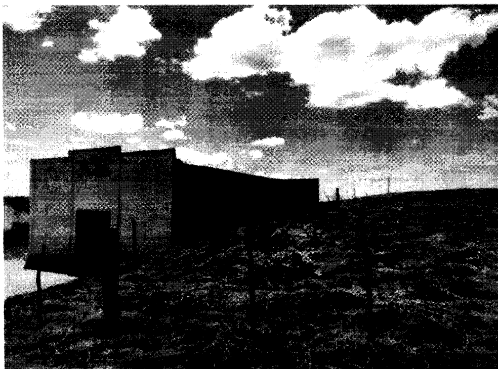
Imagem 1: Local do Reservatório, R. Keilomar de Jesus.
